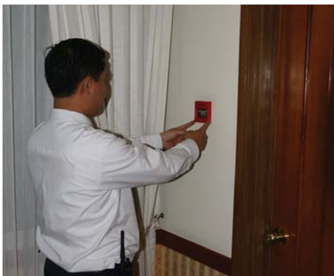
Hình 2.8. Hệ thống loa báo cháy được bố trí tại khách sạn
