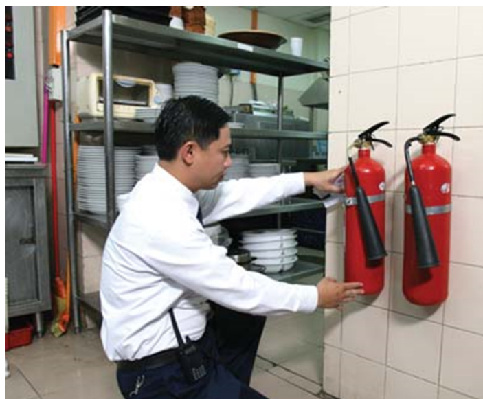
Hình 1.10. Kiểm tra thiết bị phòng cháy, chữa cháy
