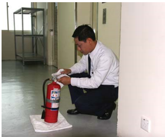
Hình 2.10. Định kỳ kiểm tra bình chữa cháy
