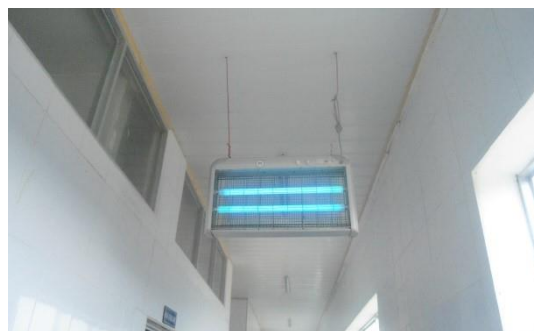
Hình 2.11. Phòng tiệt trùng bằng đèn cực tím được treo trên cao
