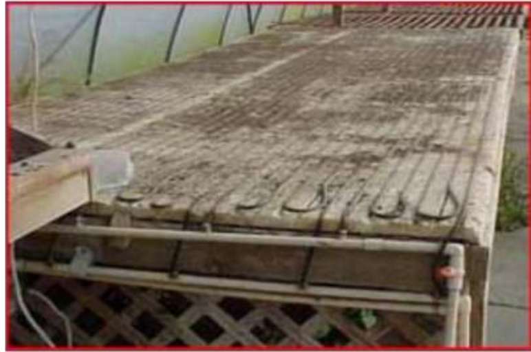
Hình: 1.1.15: Hệ thống sưởi làm nóng giá đỡ
