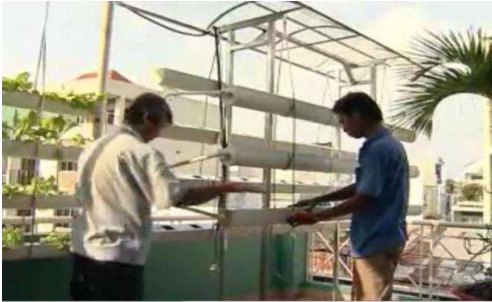
Hình 1.1.90: Lắp ráp hệ thống giàn treo
