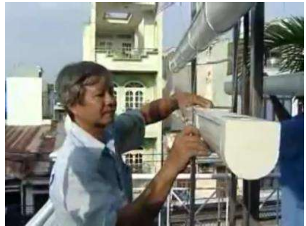
Hình: 1.1.88: Lắp ghép các ống nhựa
